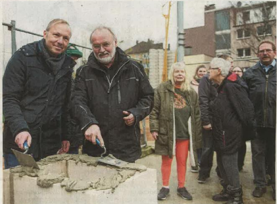
Mit viel Mörtel bereiten Lebensräume-Geschäftsführer Thomas Wittke (links) und Bauleiter Peter Probst den Grundstein des neuen Wohnheims vor. Darin wird eine Zeitkapsel eingeschlossen.
